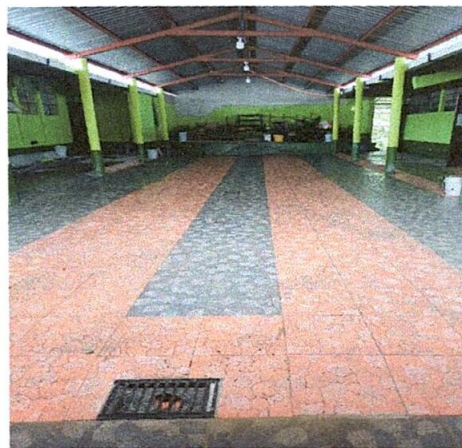
Foto 4: Instalacion de piso martillado en galera del establecimiento
