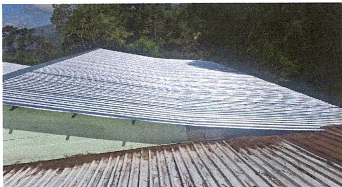
Foto 3: Cambio de entechado en 4 modulos
