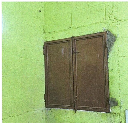
Foto 2: Instalacion de ventanas en la cocina
