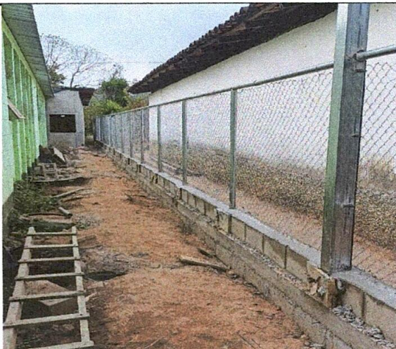
Foto1: Instalacion de malla en el perimetro del establecimiento
